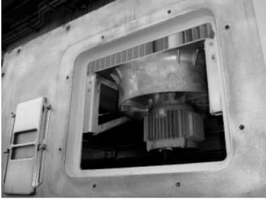
b) Afloje los 4 pernos (M8) de la placa de fijación del aspa del ventilador.
